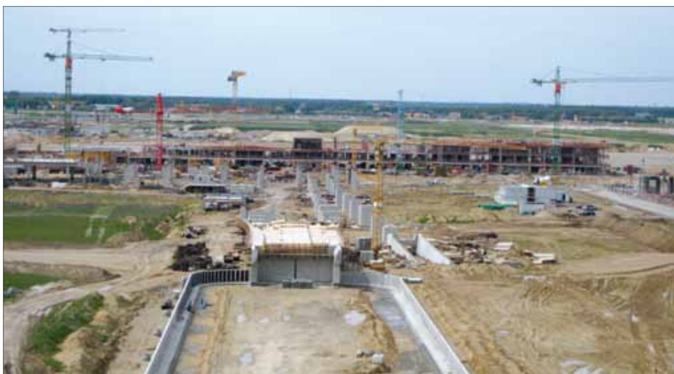
Großbaustelle Flughafen Berlin-Schönefeld
