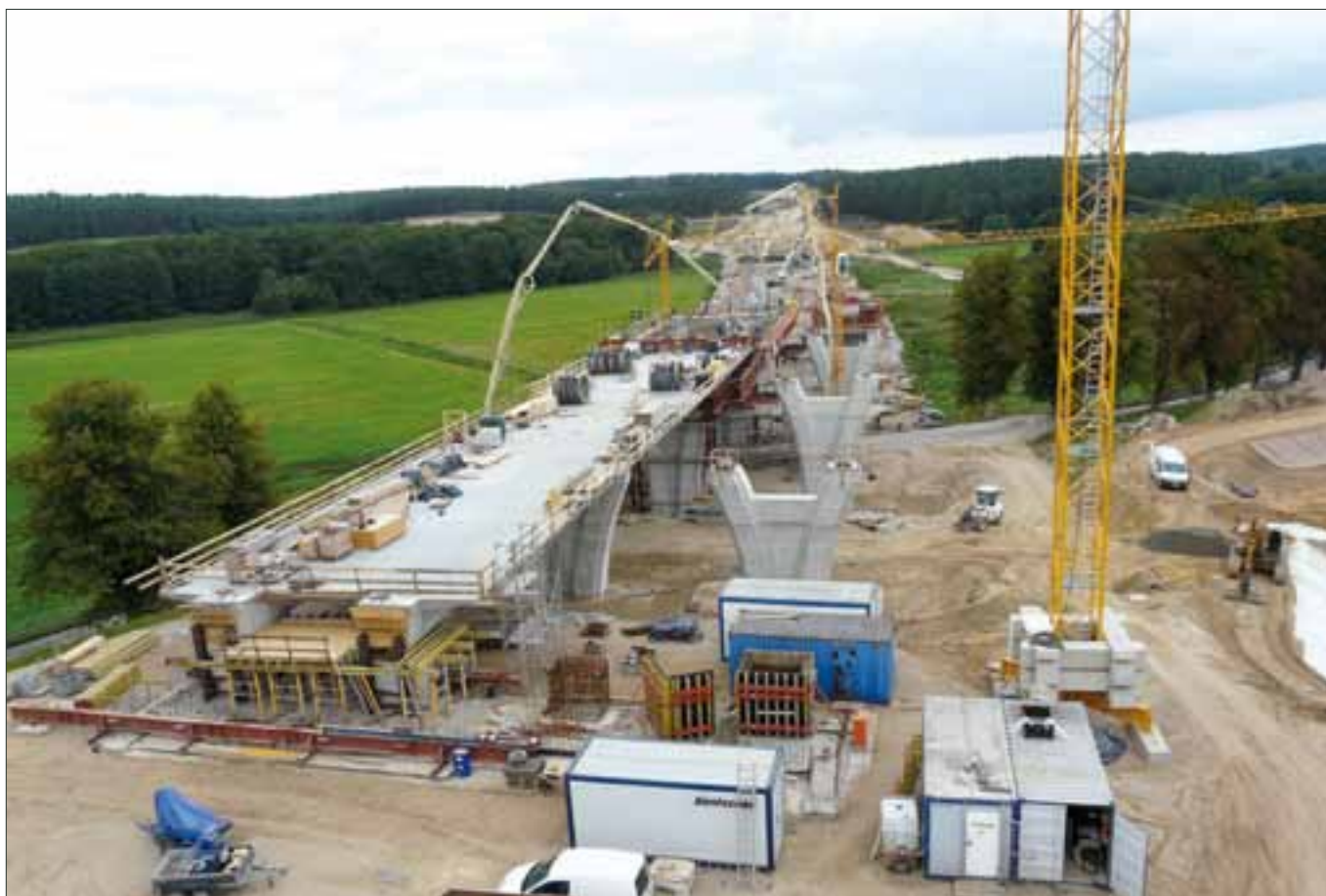
Talbrücke A14 bei Dämelow
