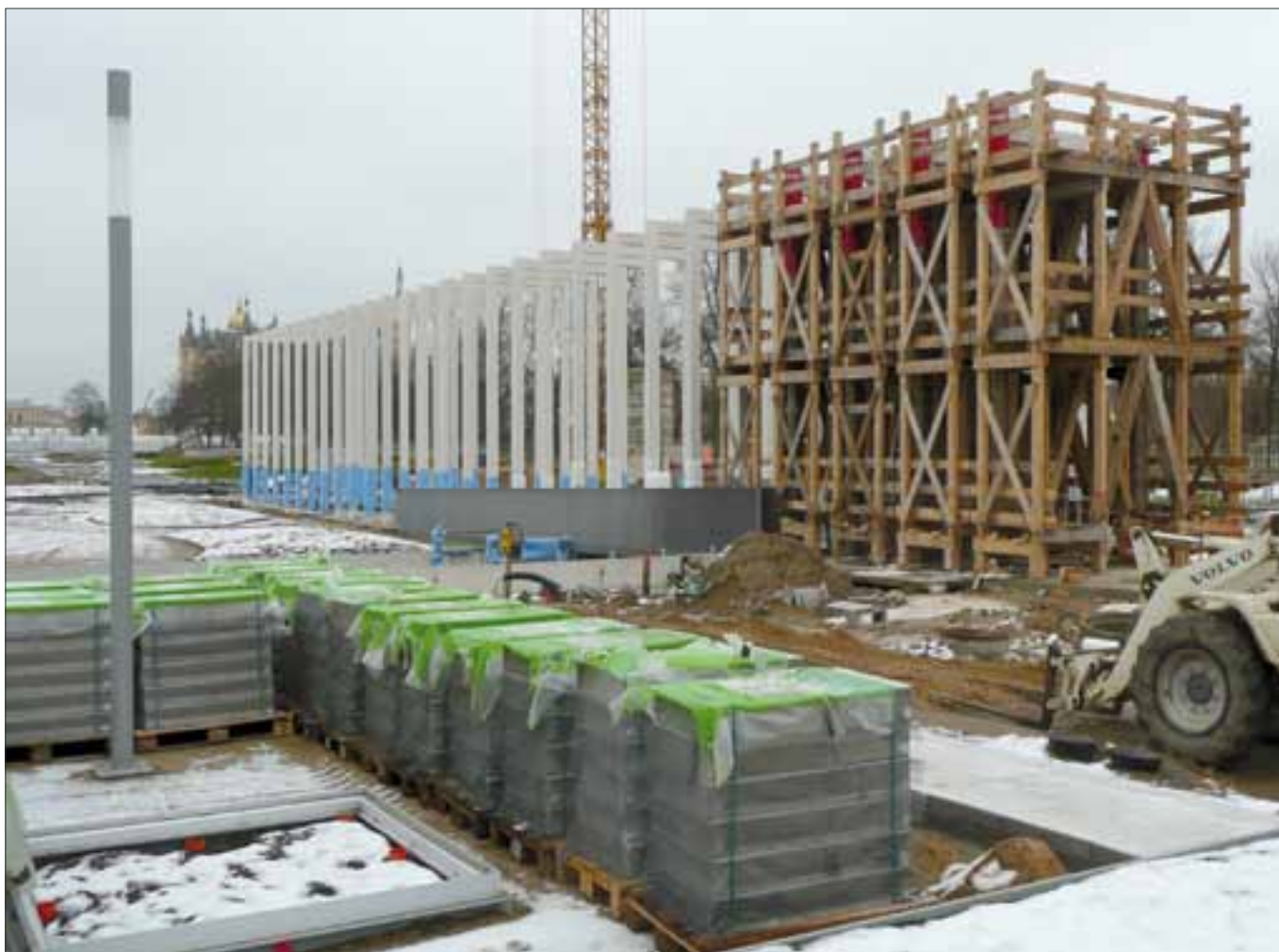
Kolonnade im Bau
