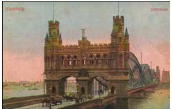
Elbbrücke von 1883-1887 erbaut, Abriss des Brückenportals 1957
