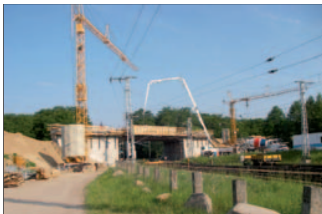
B 193 Brückenersatzneubau über die DB bei Adamsdorf
