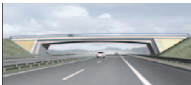
Überführungsbauwerke (Rahmen / Zweifeldlösung) Anschlussstellen; Bundesstraßen; Kreisstraßen – Arbeitsgemeinschaft Keipke / MIV
