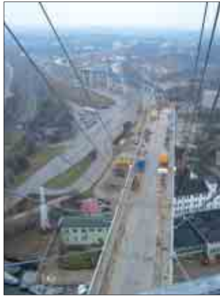
Blick vom Pylon im April 2006
