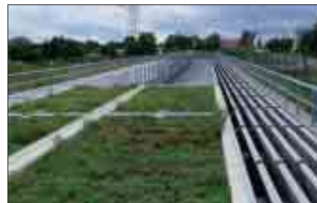
Lärmschutz-Trogbauwerk BAB A 17
