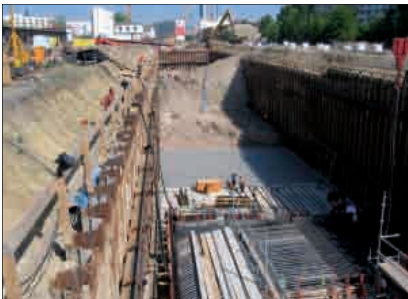
Tunnelbohrstrecke unter der Altstadt vom Bayerischen Bahnhof
