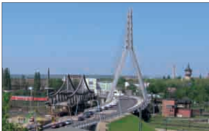
Ersatzneubau der Berliner Brücke durch die erste Schrägseilbrücke
