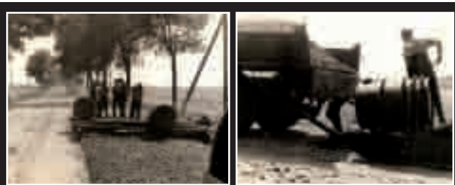
F. 103 bei Ganzlin. Einbau des Mischsplittes mit einem selbstgefertigten Schleppverteiler. 1957.
